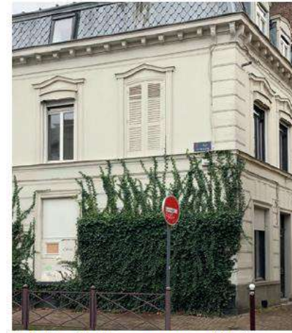
Opération « Verdissons nos murs » (Lille)
