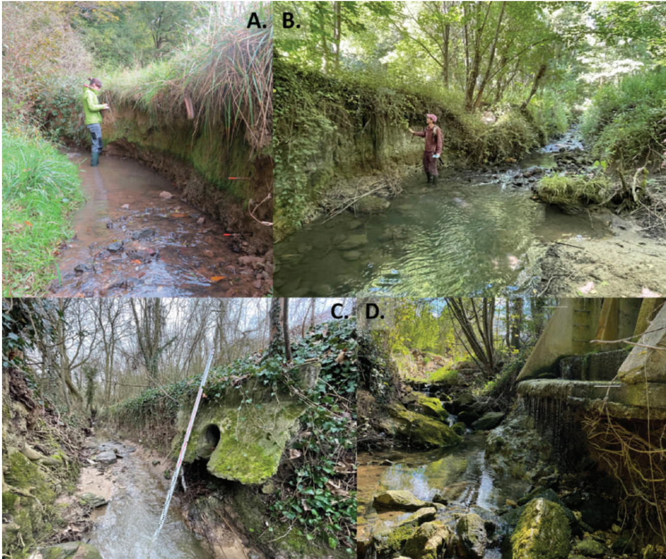
Figure 17 : Érosion du chenal en réponse à l’urbanisation des bassins versants : A. et B. Incision et élargissement de la Mérantaise, C. Incision du Morbras dans le substratum argileux, D. Incision du Ru de la Fontaine de Villiers.
