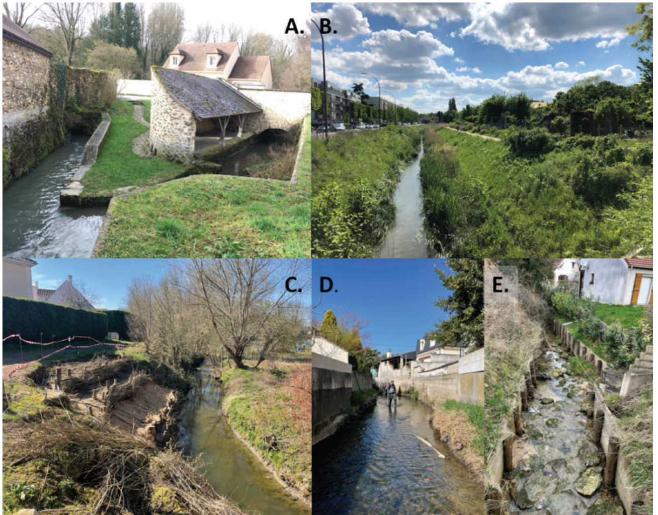
Figure 18 : Rivières urbaines aménagées : A. Mérantaise (moulin et lavoir), B. Bièvre (lutte contre les inondations), C. Morbras (lutte contre l'érosion de la berge), D. Morbras (lutte contre les inondations), E. Le Ru de la Fontaine de Villiers (lutte contre l'érosion des berges et du lit).
