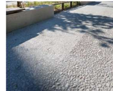
Texture de béton (Cardo decumanus) Béton bouchardé teinte claire
