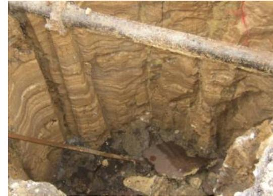
Cavité de dissolution provoquée par une fuite d'eau potable (Cerema)
