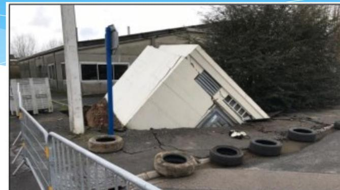
Figure III.6: Engloutissement d'un transformateur EDF à Beaurains (février 2018)
