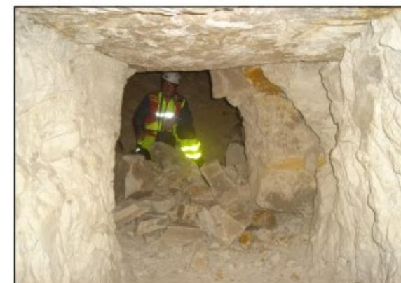
Figure III.5: Effondrement du toit (rue des Hochettes - Arras)
