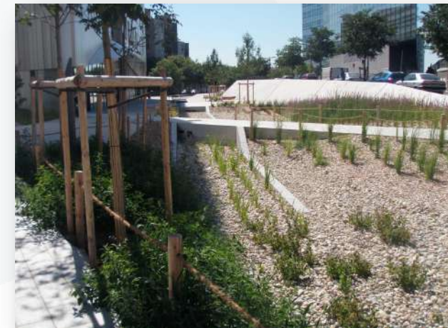
Bassin infiltration ZAC Thiers - Métropole Grand Lyon
